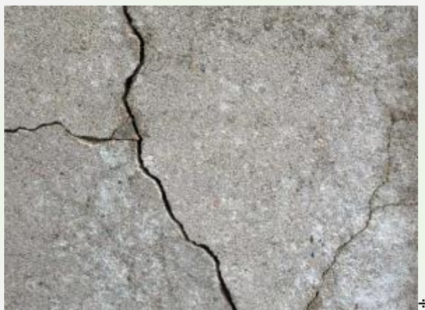
شکل ۱۰- ترک‌خوردگی ناشی از عدم رعایت اصول انبارش و حمل صحیح
