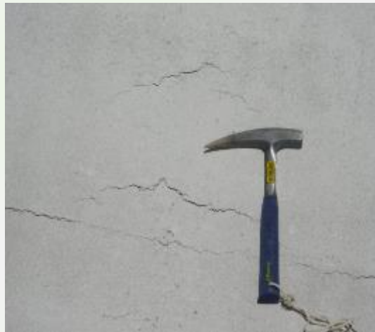
شکل ۱۱- آسیب ناشی از ترک خمیری در بتن
