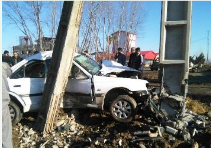
شکل ۵- صدمه وارد بر پایه در اثر تصادف وسیله نقلیه - نمونه‌ای از مخاطرات انسانی
