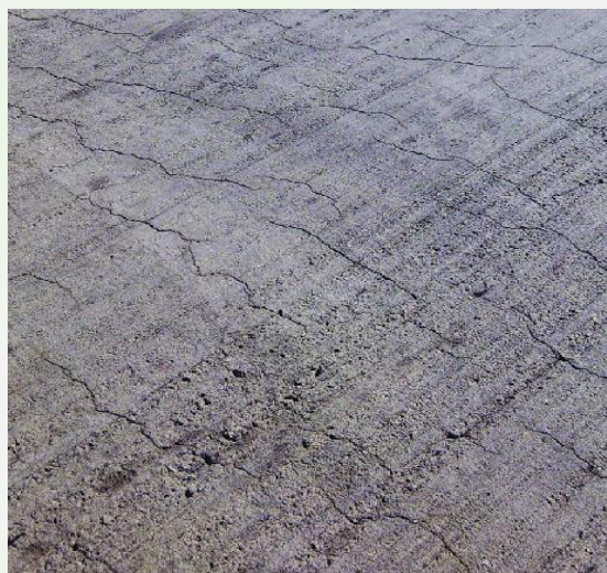
شکل ۱۲- ترک خوردگی ناشی از نشست خمیری [۸]
