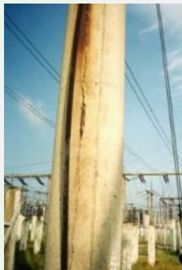
شکل ۹- ترک طولی در پایه‌ی بتنی پیش‌تنیده با مقطع گرد
