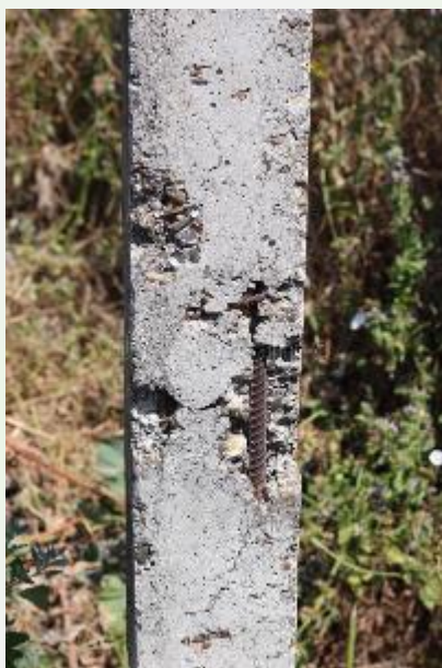
شکل ۱۶- کرمو شدگی و ریزش پوسته بتن [۱۱]
