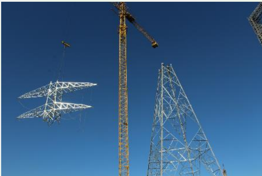
شکل ۱. دکل KZT4-30 در حال مونتاژ عمودی
