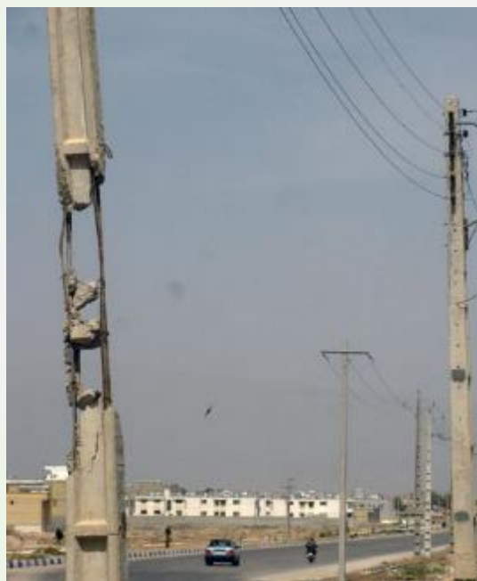
شکل ۴- زوال بتن و میلگرد در اثر رطوبت در جنوب کشور - نمونه‌ی مخاطرات محیطی
