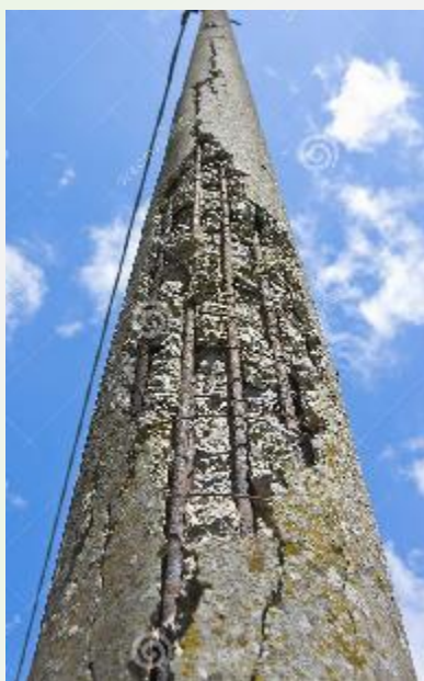
شکل ۱۵- جداشدگی و ریزش پوشش بتن در اثر خوردگی میلگرد [۱۱]
