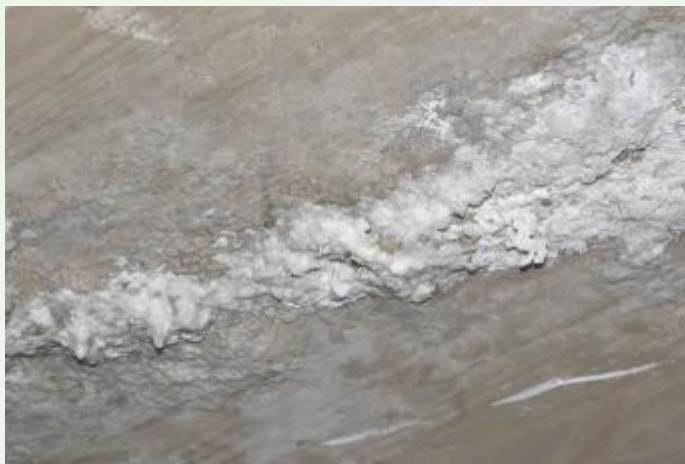
شکل ۱۴- آسیب ناشی از حمله سولفات به سازه‌ی بتنی و تشکیل شوره بر سطح بتن [۹]
