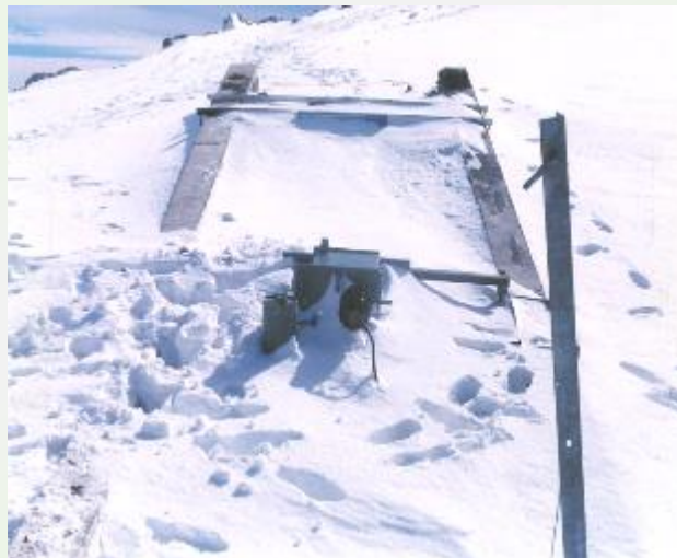
شکل ۳- واژگونی پایه‌ی بتنی در اثر بارش برف سنگین - لرستان - ۱۳۸۷ [۳]
