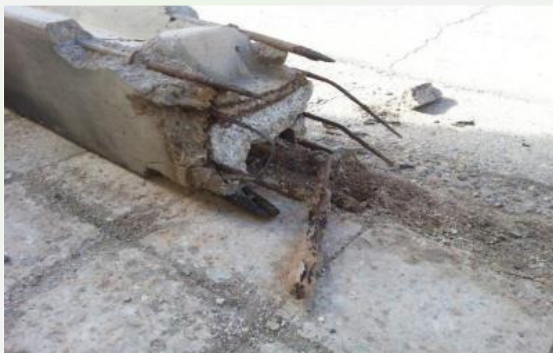
شکل ۷- خوردگی میلگرد در اثر قرارگیری در معرض رطوبت
