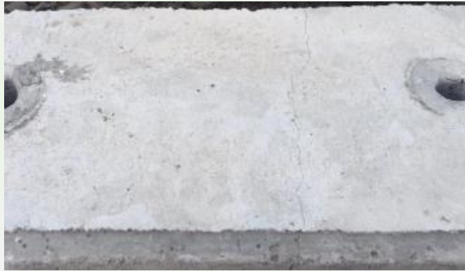
شکل ۱۳- ترک عرضی ناشی از انبارش و یا حمل غیراصولی [۴]
