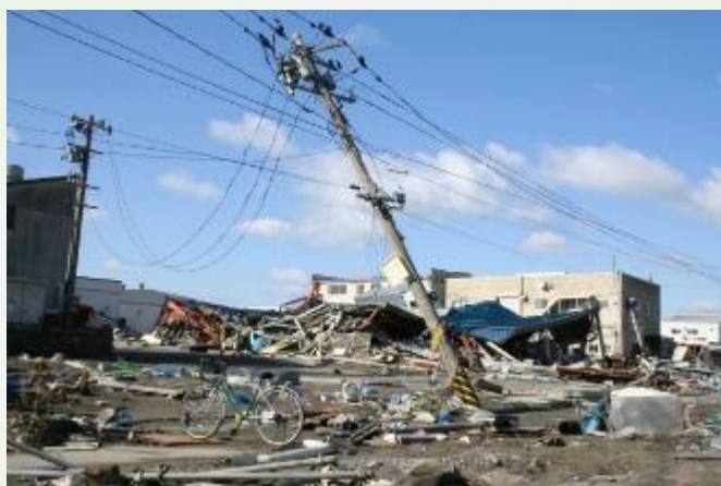
شکل ۲- واژگونی پایه برق در اثر زلزله - نمونه‌ای از مخاطرات محیطی [۱]
