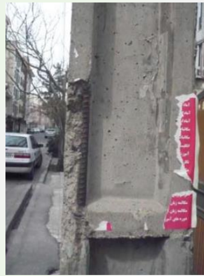
شکل ۶- عدم طراحی یا اجرای نادرست پایه‌ی بتنی (راست) و طرح اختلاط نامناسب و یا ساتریفیوژ با سرعت نامناسب در پایه‌های بتنی گرد (چپ)
