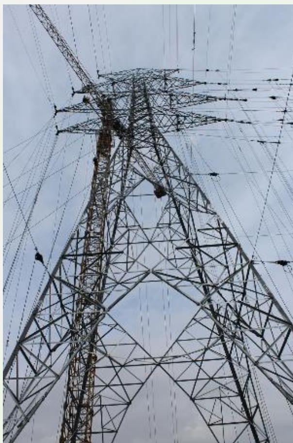
شکل ۲. نمونه‌ای از نحوه اتصال کابل‌های اعمال نیرو بر روی دکل KZT4-30
