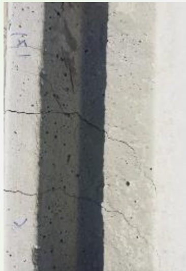
شکل ۸- ترک های خمشی ناشی از بارگذاری بیش از حد مقاومت اسمی پایه [۴]
